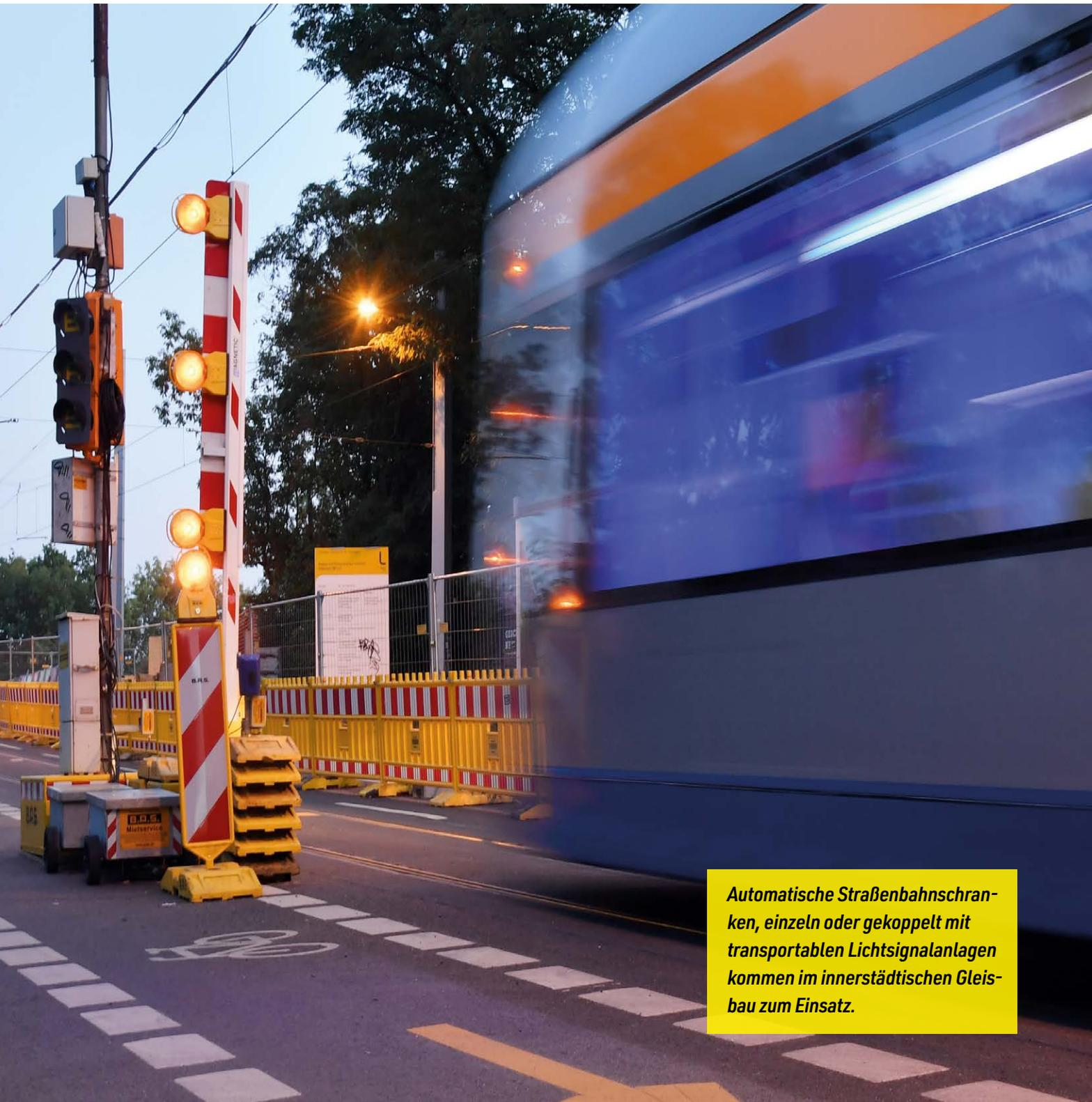
*Automatische Straßenbahnschranken, einzeln oder gekoppelt mit transportablen Lichtsignalanlagen kommen im innerstädtischen Gleisbau zum Einsatz.*
